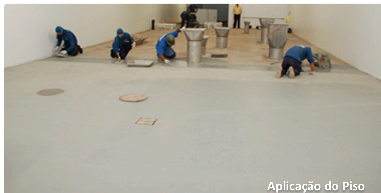
Aplicação do Piso
