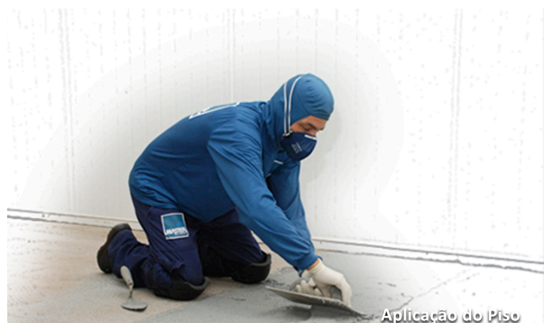
Aplicação do Piso
