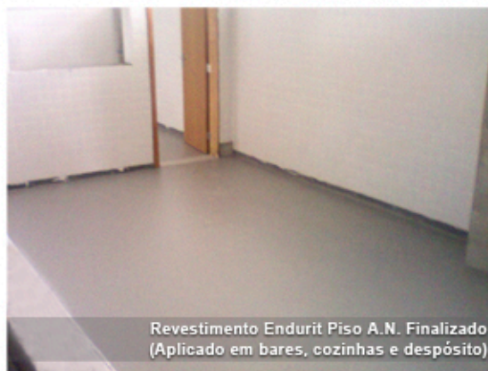
Revestimento P 500 B Finalizado (Aplicado em áreas de circulação geral)
