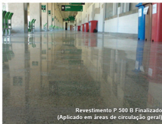
Aplicação de Adepox Fix e P 500 B Cime AR Top 72 (Aplicado em áreas de circulação geral)
