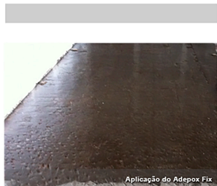
Aplicação do Adepox Fix
