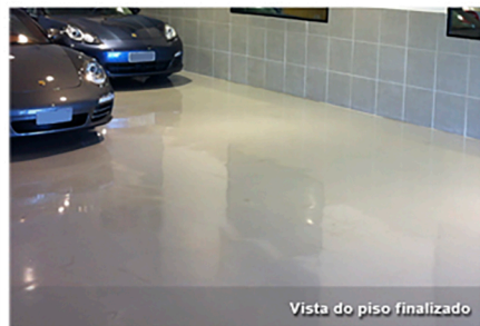
Vista do piso finalizado
