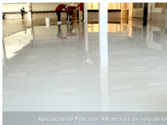
Substrato imprimado para a adesão de Poxcolor AN
