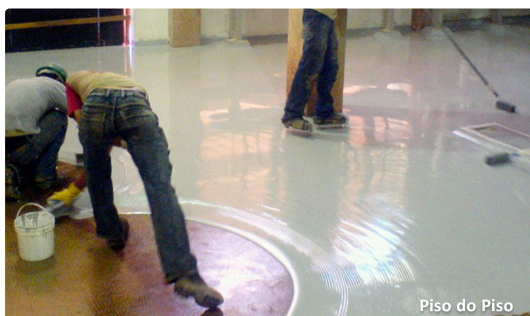
Aplicação de primer e carga mineral
