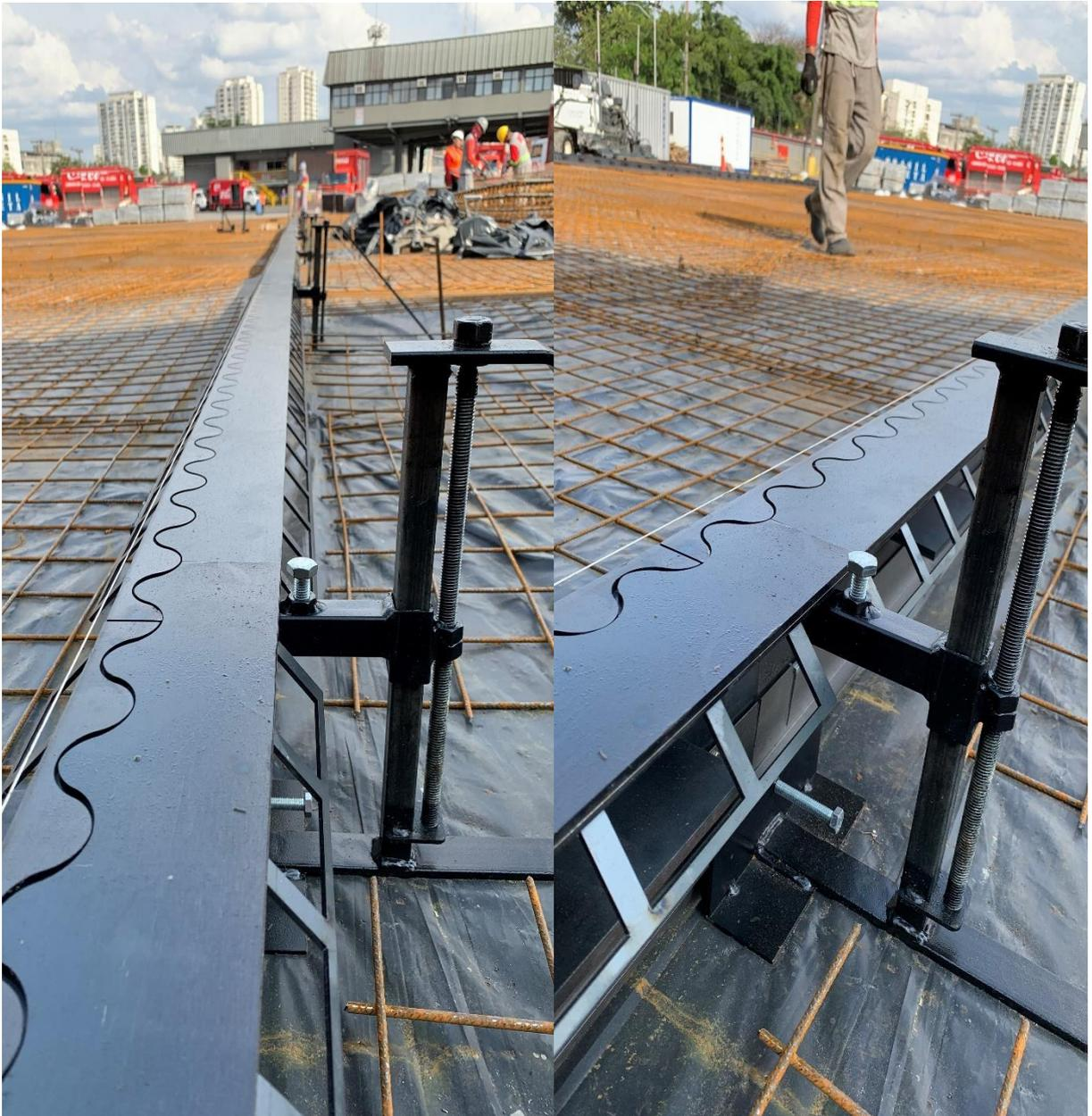
Inserir o suporte quadrado dentro do braço do nivelador, assim regulando a altura da junta conforme projeto geométrico do piso, lembrando que é necessário regular também a inclinação com o parafuso da base do nivelador. A Junta senoidal contem a regulagem de altura em sua base, podendo ser regulada de acordo com a altura do piso, dentro de intervalos, produzidos por peça.
