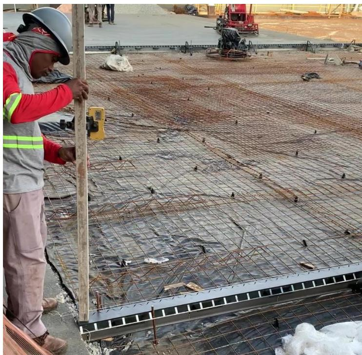
Depois de nivelada e ajustada conforme projeto do piso é recomendado fixar na extremidade dos niveladores e uma barra de construção com grapas de madeira, para impedir que a junta se desloque com o volume de concreto.
