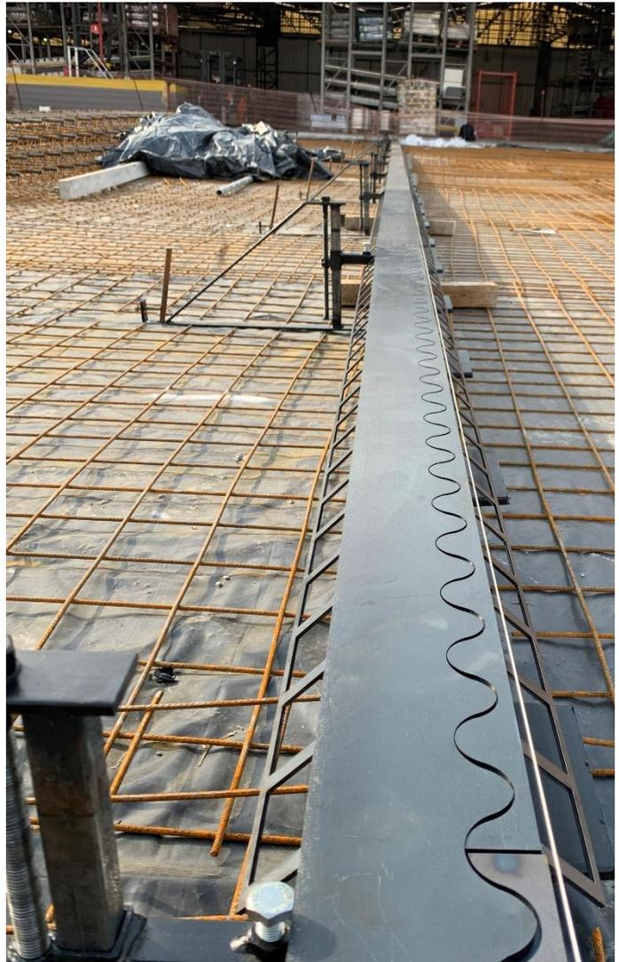
Posterior a essa etapa e colocação dos niveladores em todo perfil e comprimento das peças, é de suma importância ajustar a altura e inclinação com o nível a laser ou ótico.
