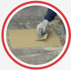
Poliplus: Línea de argamasa cementosa de rápido secado, con liberación de tráfico entre 1-4 horas. Desarrollada para reparaciones de emergencia en las cuales el tiempo de paralización debe ser el menor posible.
