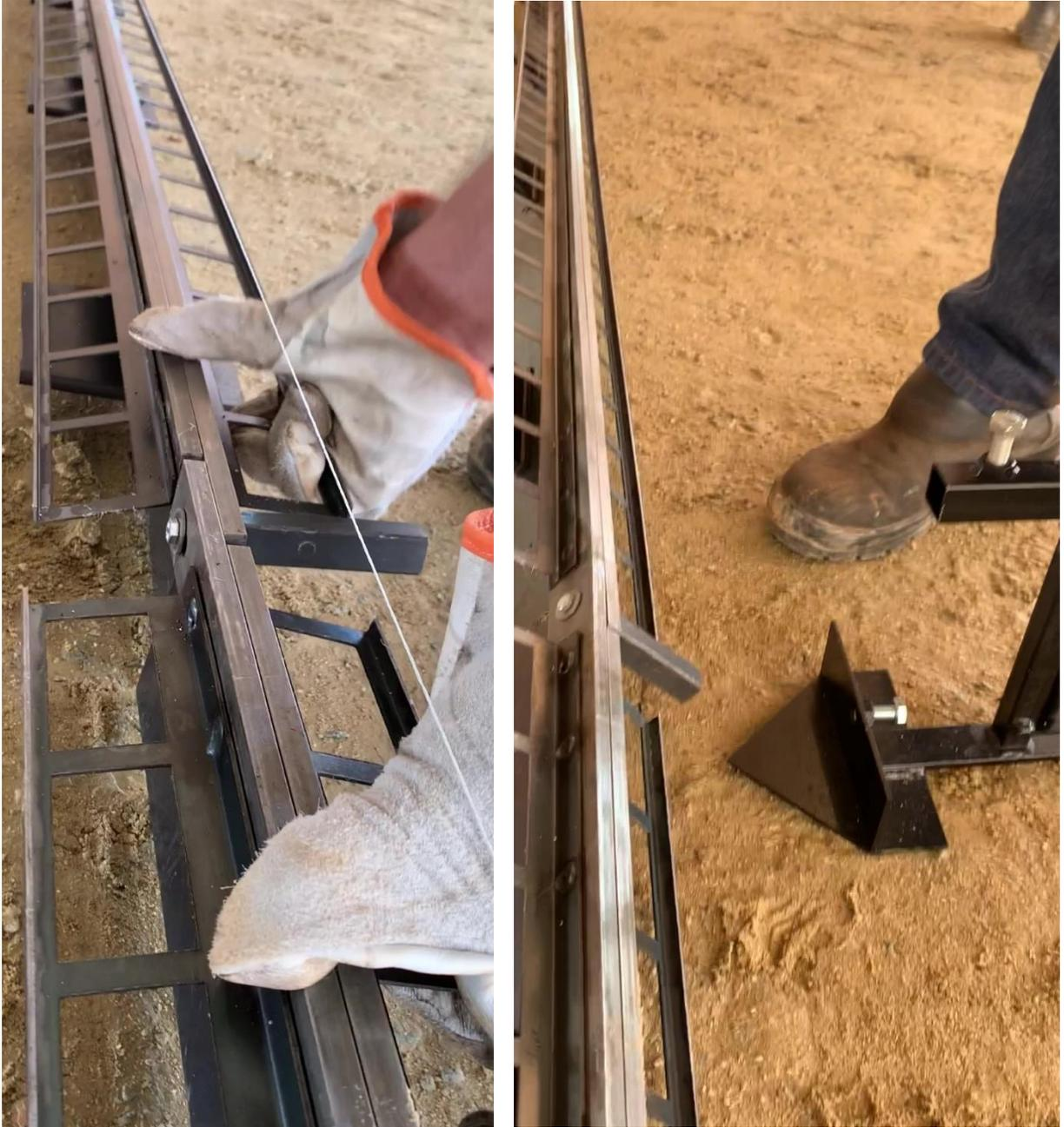
Inserir o suporte quadrado dentro do braço do nivelador, assim regulando a altura da junta conforme projeto geométrico do piso, lembrando que é necessário regular também a inclinação com o parafuso da base do nivelador.
