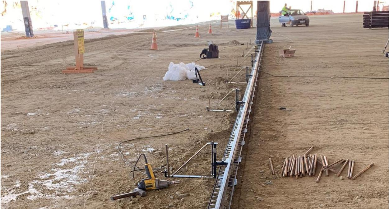
Após a junta nas condições ideais citado acima, a mesma encontra-se pronta para receber o concreto do lado posterior ao nivelador. É importante que a junta receba a concretagem do lado da barra de transferência que tem a capa plástica, pois o concreto retraindo irá deslocar a capa da barra, não interferindo na estrutura da junta.
